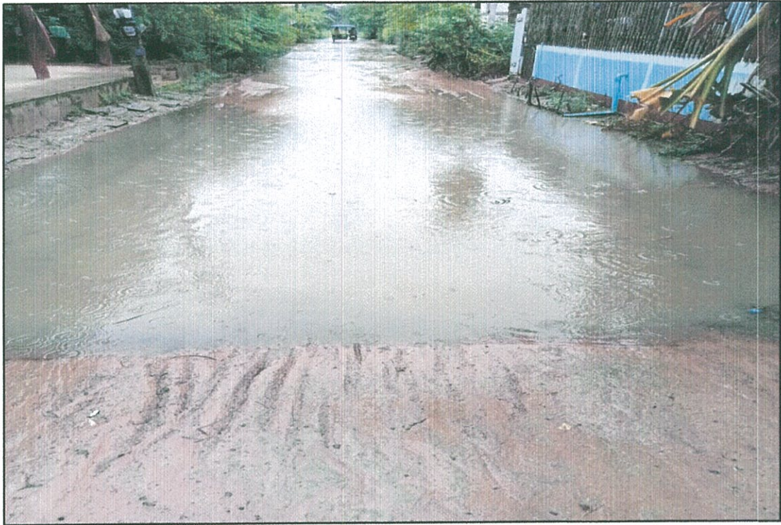
จุดซ่อมแซม หมู่ ๑ ถนนคอนกรีตเสริมเหล็กภายในหมู่บ้าน
